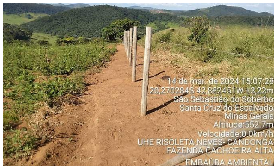
Figura 23 – Aceiro de proteção implantado.
